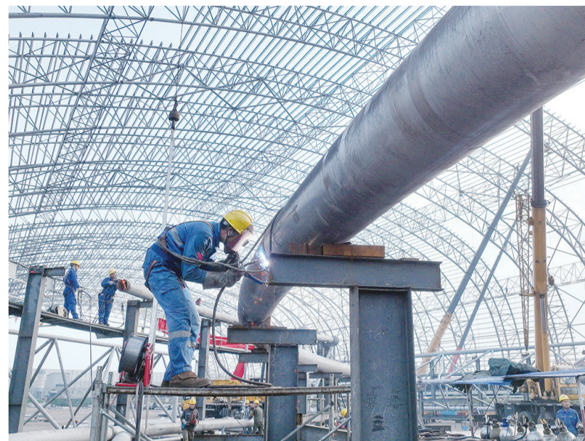
7月24日,工人在唐山港曹妃甸港区煤码头封闭式煤炭堆场条形储备仓建设工地施工(无人机照片)。近日,河北省唐山港曹妃甸港区煤码头三期工程后续建设项目封闭式煤炭堆场条形储备仓建设正在稳步推进。据介绍,该储备仓储备设计能力93万吨,是曹妃甸港区推进煤尘抑制、减少污染的重要环保设施。 新华社发
