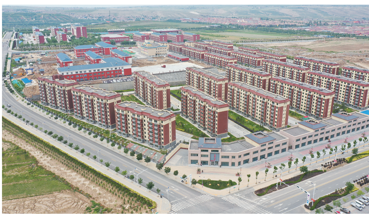
8月17日,记者在海原县北苑小区看到,小区道路、给水、供电、供气、污水排水管网、绿化、照明、垃圾收集等功能分区基本形成,环境优美、绿化舒心。自全面启动棚户区改造以来,海原县累计完成拆迁9101户、征地12582亩,建成北苑等安置小区8个、富民花园等开发商住小区10个,共回迁安置11170套,着力改善县城环境,提升城市功能。
