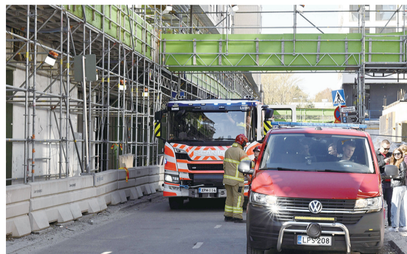
5月11日,在芬兰首都赫尔辛基以西城市埃斯波,救援人员在天桥倒塌事故现场工作。芬兰首都赫尔辛基以西城市埃斯波5月11日上午发生人行天桥倒塌事故,致27人受伤,其中多数是未成年人。新华社发
